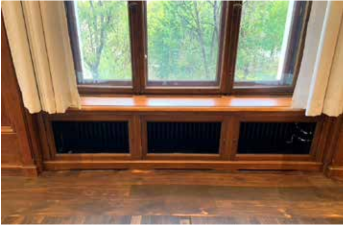
Moderne Anforderungen im historischen Umfeld: Einbau von Fensterinnenbänken und Heizkörperverkleidungen. Quelle: RSP GmbH
