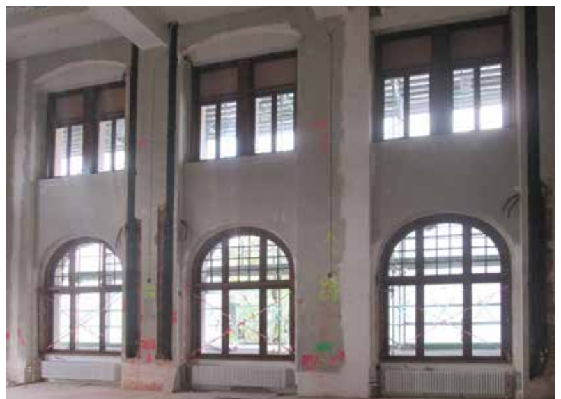
Alter Sitzungssaal nach Demontage der historischen Holzvertäfelung. Quelle: RSP GmbH
