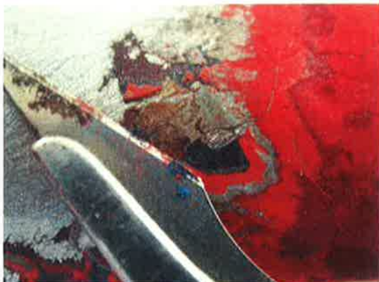
Lackschichtenaufbau im Bereich der Blattfedern
